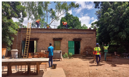
Installation des panneaux solaires
